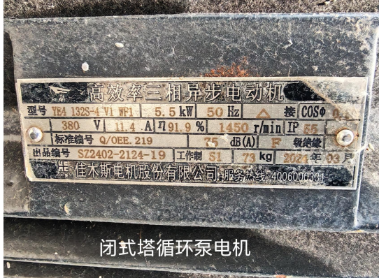
闭式塔循环泵
