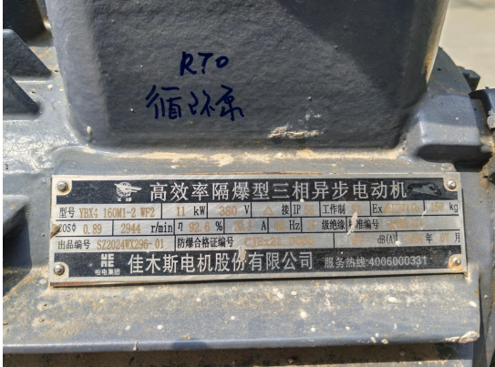
RTO 循环泵电机
